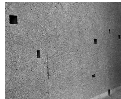
WOHNBEBAUUNG SÄGEMATT, SEMPACH (Wohnumfeldgestaltung) Planung und Realisierung: 2004–2006 Bauherrschaft: Schärli Architekten AG, Luzern Architektur: Schärli Architekten AG, Luzern
